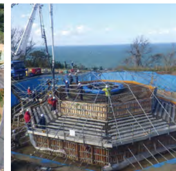
風力発電設備基礎工事
