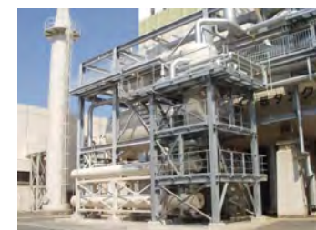
蒸気発生器ブローダウン水熱回収装置設置
