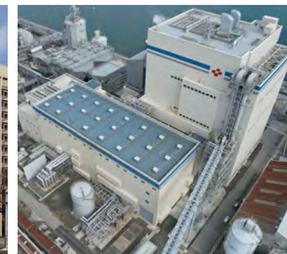
西条発電所1号機 タービン建屋新築工事
