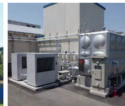
イシイフーズエコキュート導入工事
