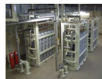
ハロン消火設備設置
