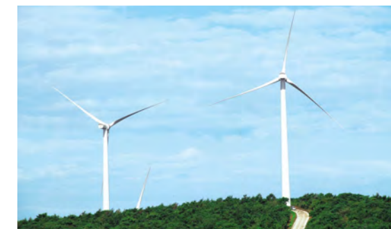
穎娃風力発電設備
