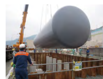
補助ボイラ燃料タンク据付
