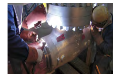
電気事業法 溶接認可対象配管の施工
