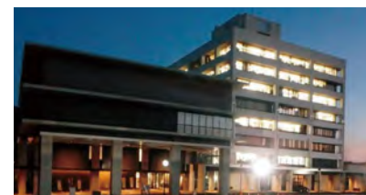
宇和島庁舎電気設備工事
