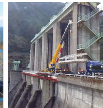
水力発電所 ダムゲート修繕工事
