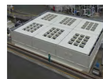
取水設備電巻防護対策設備設置
