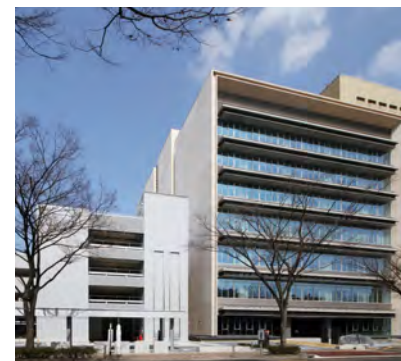
高松市危機管理センター等建設工事
