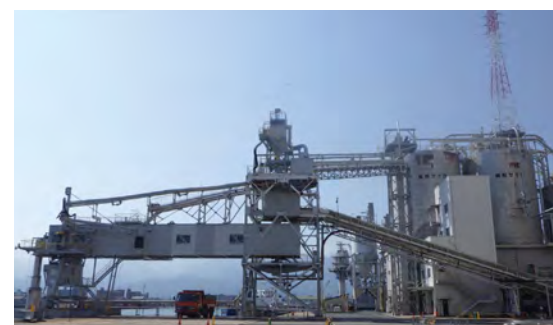
四国電力(株)西条発電所 フライアッシュ船積設備
