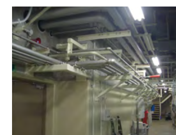
ハロン消火設備配管布設
