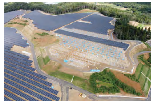
太陽光発電所建設工事
