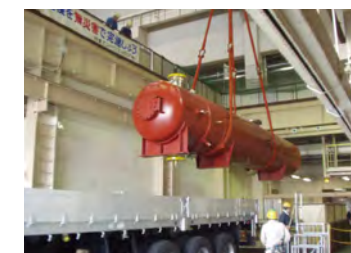
第3低圧給水加熱器取替
