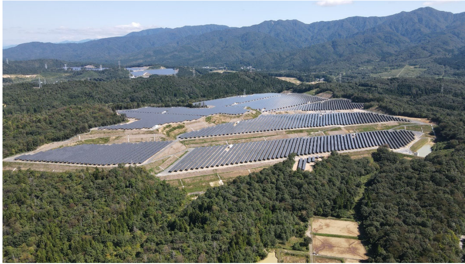
<大室メガソーラー発電所 全景写真>
