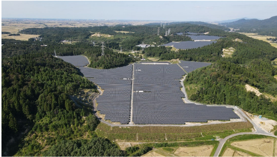
<大日メガソーラー発電所 全景写真>
